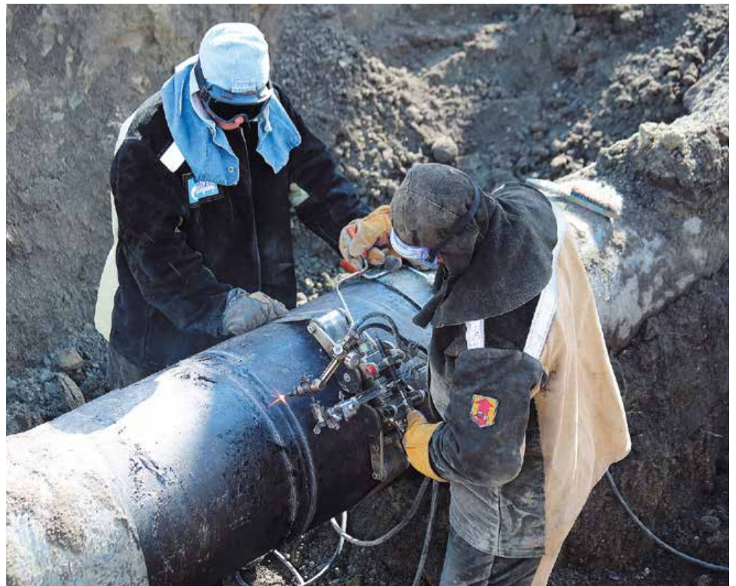
Газопровод Шкапово–Ишимбай построен 60 лет назад
